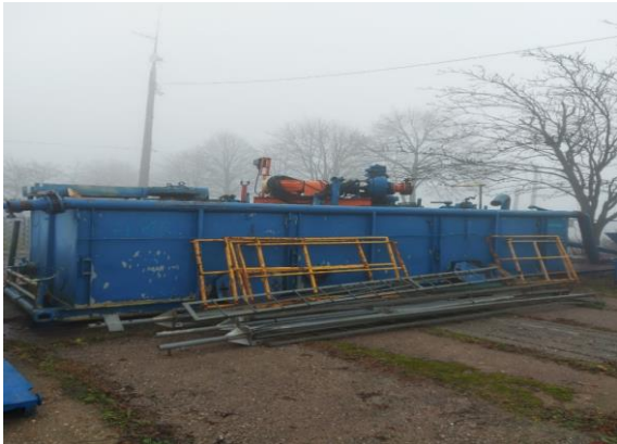
29. ZBIORNIK WODY 6040000499 Libusza
